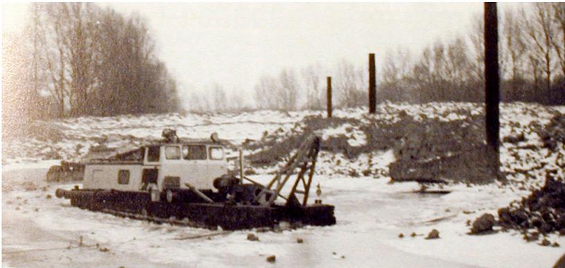
spundet, ist unten 12 m und an der Böschungsoberkante 22 m breit. Bei Pegel Null ist noch eine Wassertiefe von 1,60 m vorhanden.
